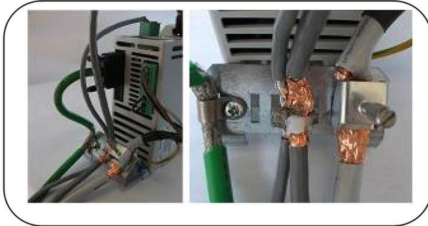
Рис.1. Примеры присоединения экранов кабелей со стороны привода
