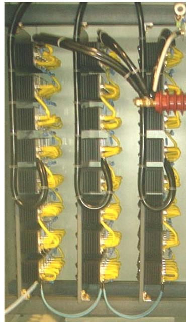
Figura 4.1.d4: gruppo raddrizzatore alta tensione
